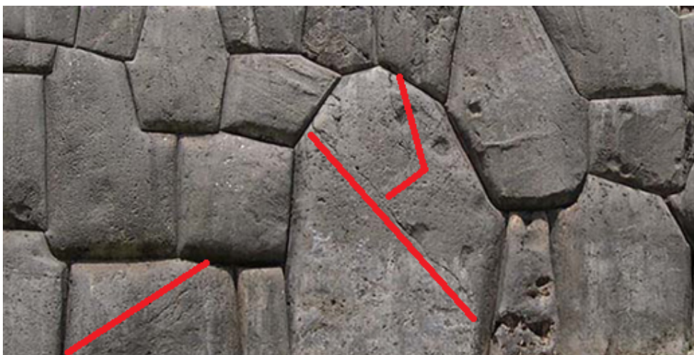
Рис. 13. Следы завершённой ручной обработки камня по линиям разлома. (Фото из свободного доступа в Интернете).
