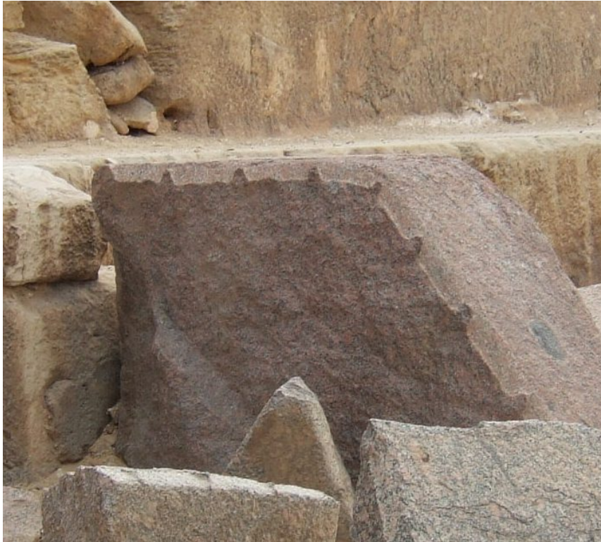
Рис. 77 Следы надкола для деления камня в нужном направлении (предположительно, по структуре гранита). Фото из свободного доступа в Интернете.
