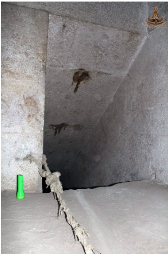
Рис. 29 Плетённый канат с ухватами. Чуть правее видны следы с потёртостями на пандусе от трения каната при подъёме камня. Фото из архивов исследовательского сообщества по изучению древних артефактов ( http://isida-project.org )
